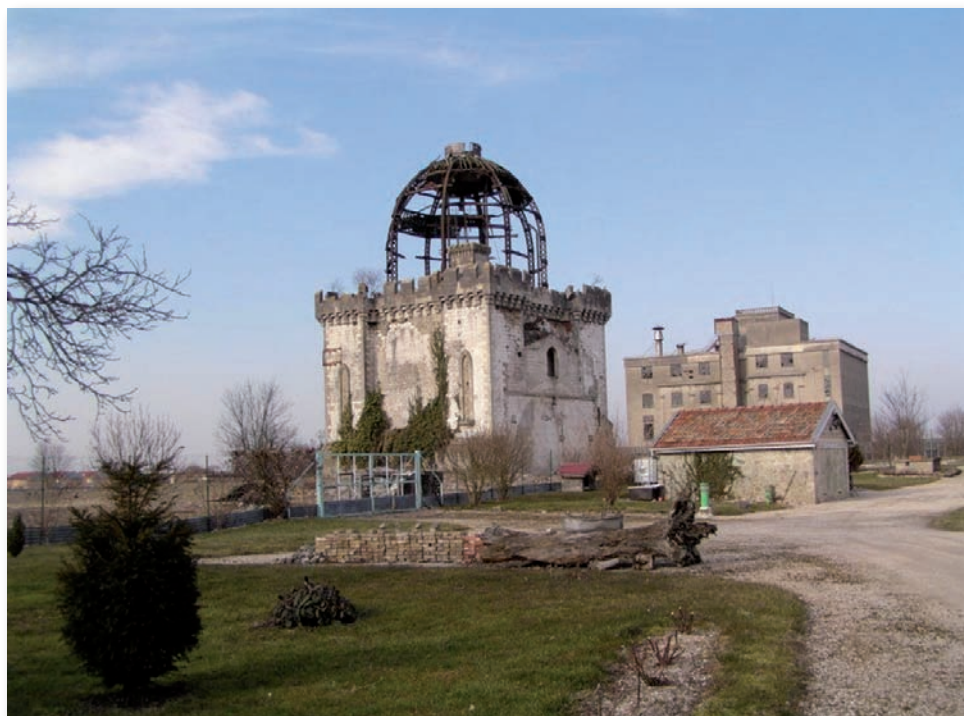
La tour de la distillerie de la Comète (Châlons en Champagne) Photo J.M. Duquénois
