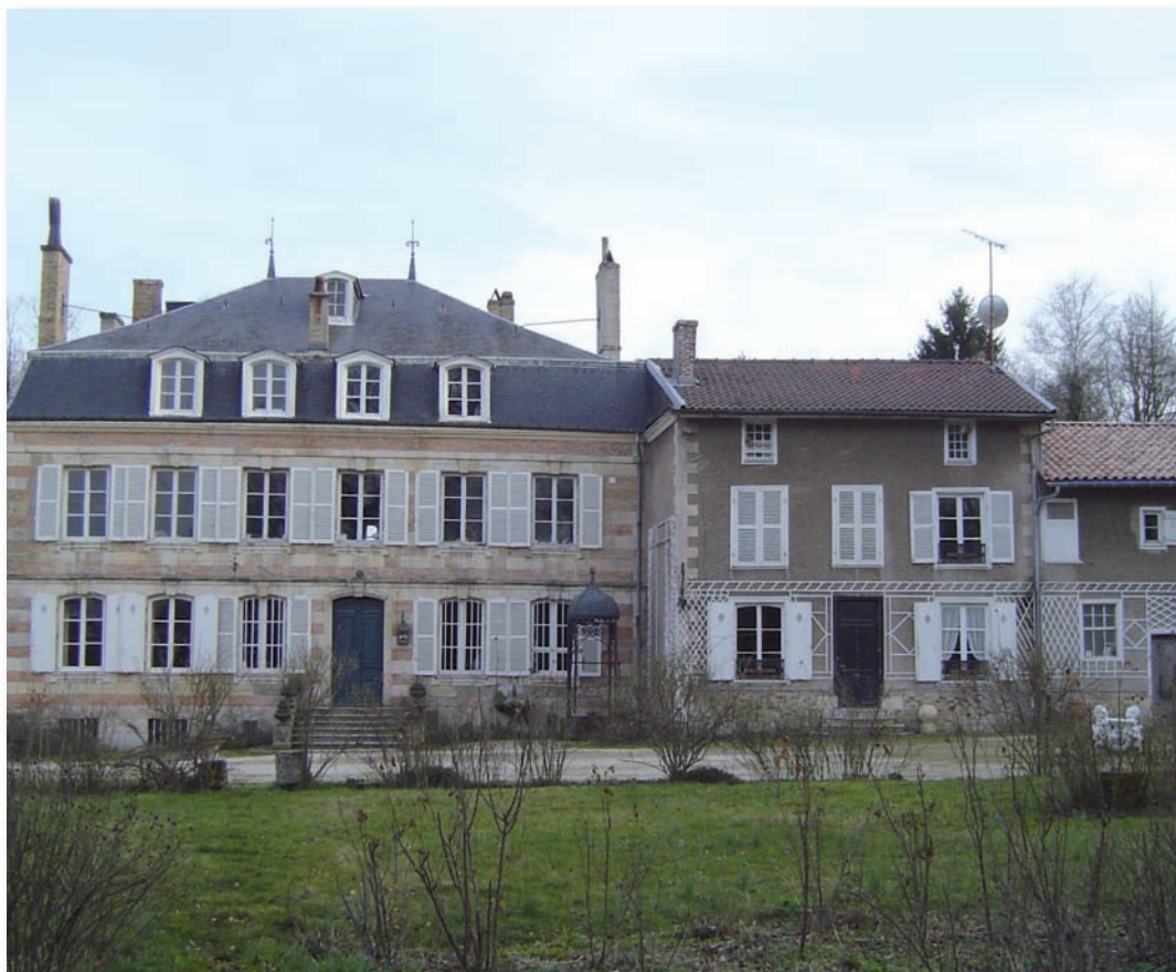
Faïencerie des Islettes (Marne) maison de maître et dépendances. (Photo S. Druet)
